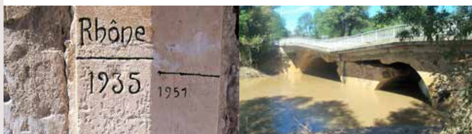
Repère de crues
