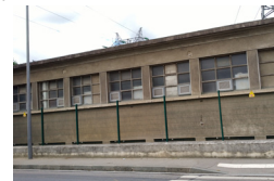
Avenue Jean Jaurès, bâtiments de la centrale EDF, RDC surélevé.
