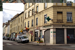
Rue du bac, commerce au RDC non surélevé.
