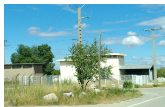
Rue Henri Moissan, la station de relevage
