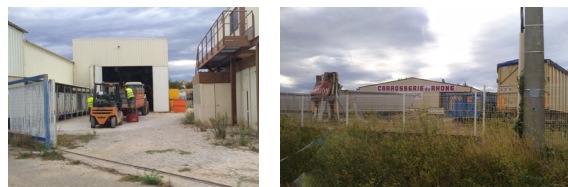
Entrepôt, bâtiments préfabriqués
