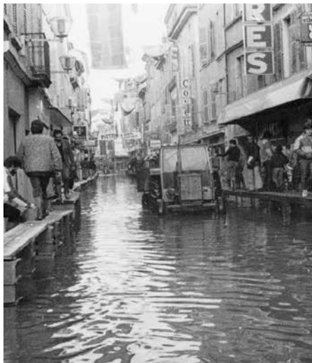
Rue Carnot à Macon - 1981
