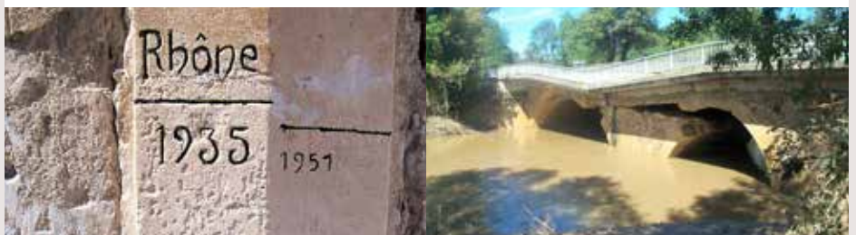
Repère de crues
