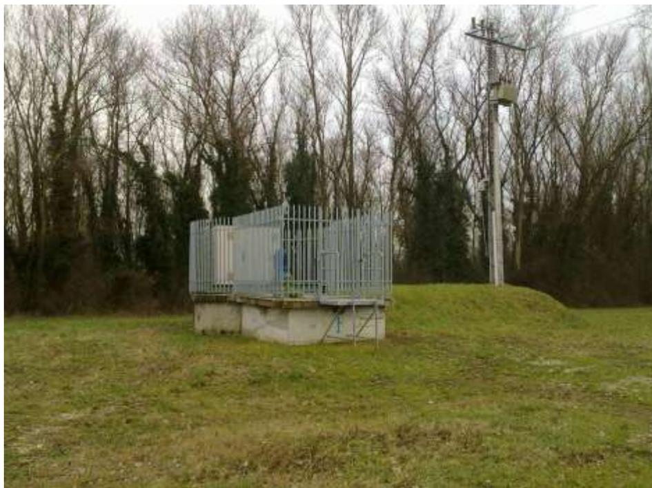
**Figure 17 : Armoire située sur une tête de puits surélevée et transformateur électrique sur pylône (SAFEGE)**
