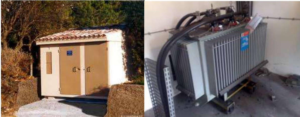
Figure 12 : Poste de transformation électrique HTA/ BT - vue externe et vue interne (MEDDTL)
